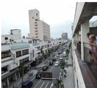
山形市内スズラン街の防火建築帯
