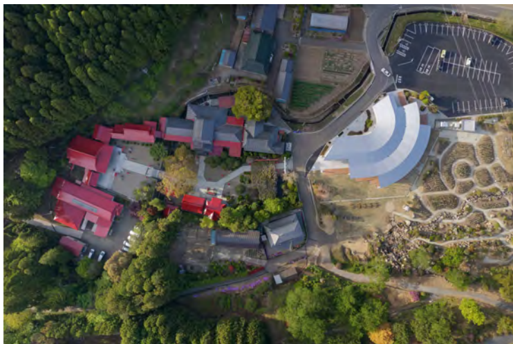
駐車場と境内を繋ぐ円弧状の屋根
