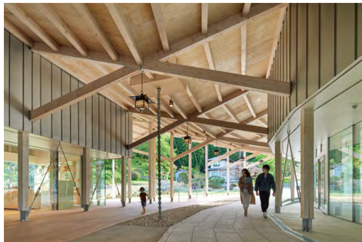
建物を貫通する参道
