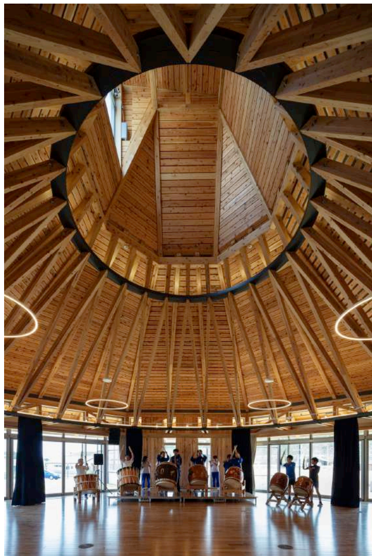
地域の方々との対話から生まれた「風のホール」。伝統構法「船外づくり」を継承
