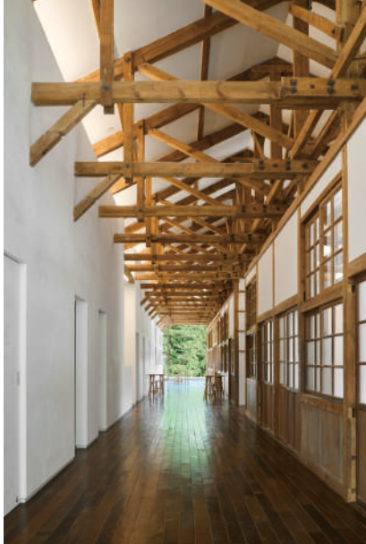
四辻ギャラリー：水回り側の新設壁は、地場の石材粉末を漆喰に混ぜ込み、手作業での磨き仕上げとした
