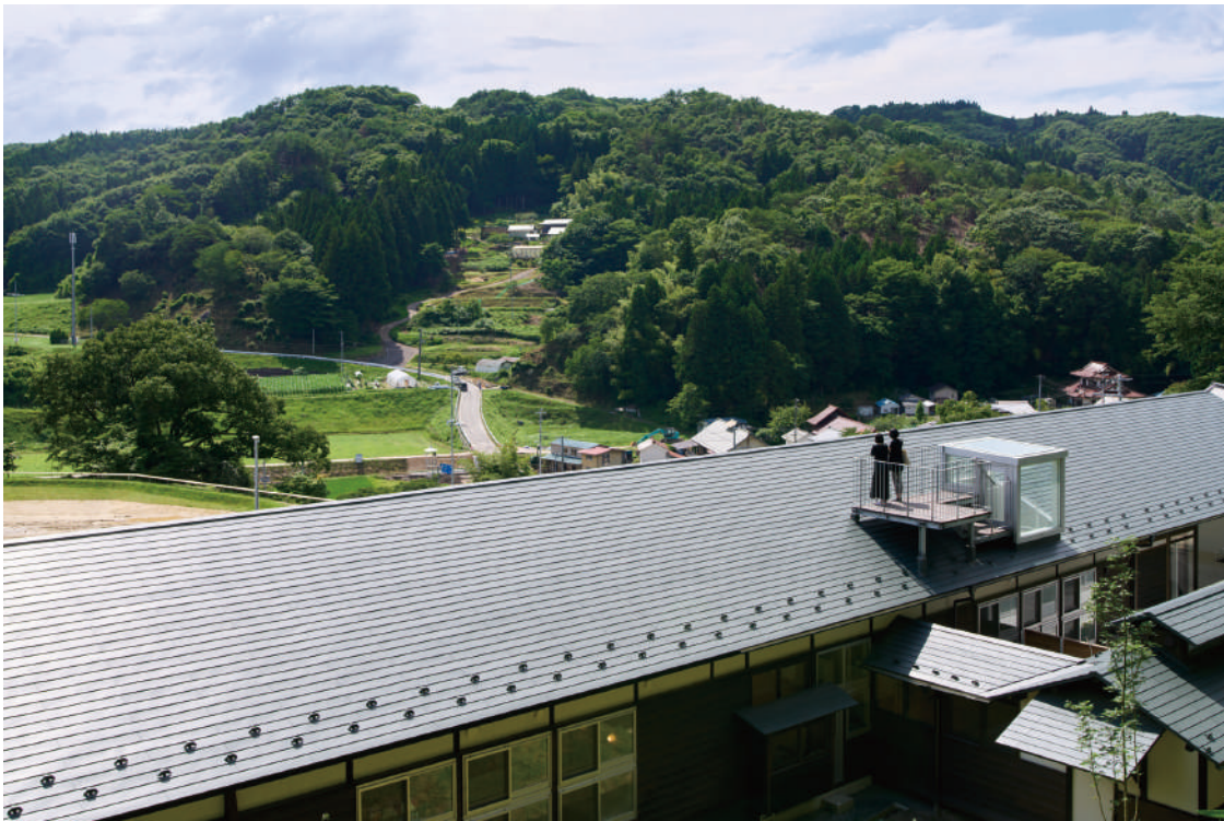
崖地側から屋根上テラスを見る：屋根上テラスは、校庭からの既存の外観を残すため、棟の高さを超えない高さに設定した
