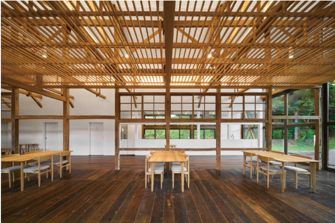
旧音楽体育室 (カフェレストラン)：廊下との間の界壁に用いられていた柱・建具を手前に移設し、天井木ルーバーは既存の高さに合わせた
