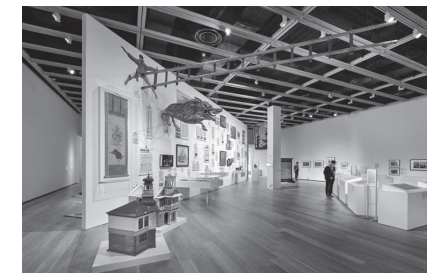
ホワイトキューブ/天井金物で仮設壁・照明を自由に配置可能
