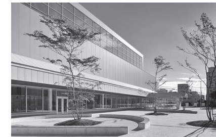
オクニワ/ポリウムは段々状にセットバックし圧迫感を低減
