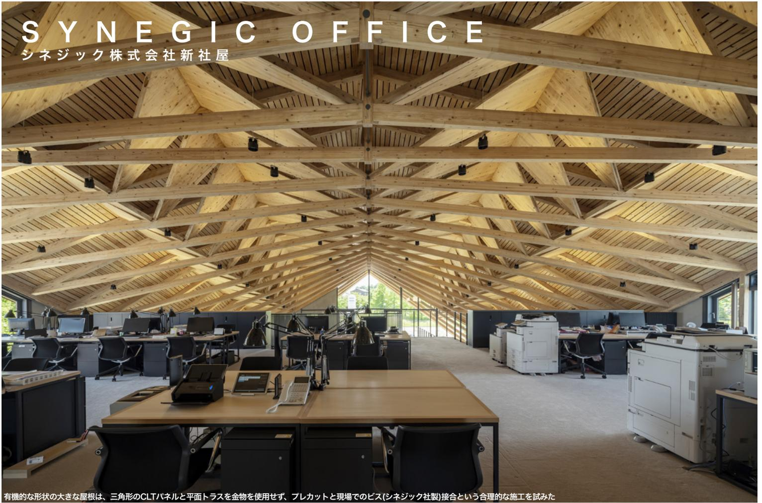
有機的な形状の大きな屋根は、三角形のCLTパネルと平面トラスを金物を使用せず、プレカットと現場でのビス(シネジック社製)接合という合理的な施工を試みた
