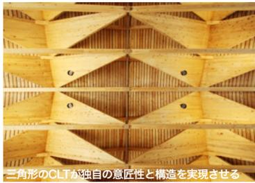
三角形のCLTが独自の意匠性と構造を実現させる
