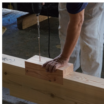
重ね梁に飼い木を打ち込む
