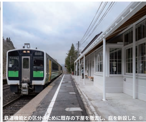
鉄道機能との区分のために既存の下屋を撤去し、庇を新設した
